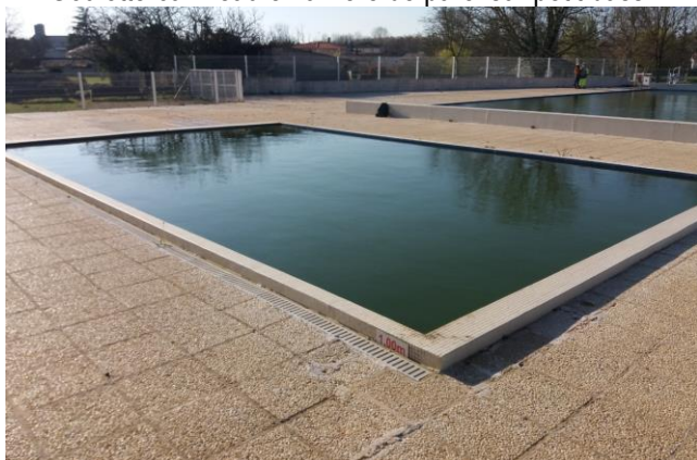
Goulotte-caniveau en arrière de paroi sur petit bassin
