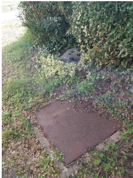
Figure 23 : puit de forage
