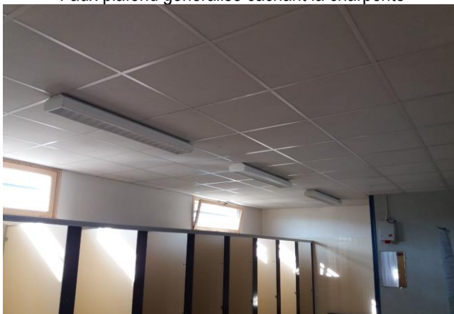
Faux plafond généralisé cachant la charpente
