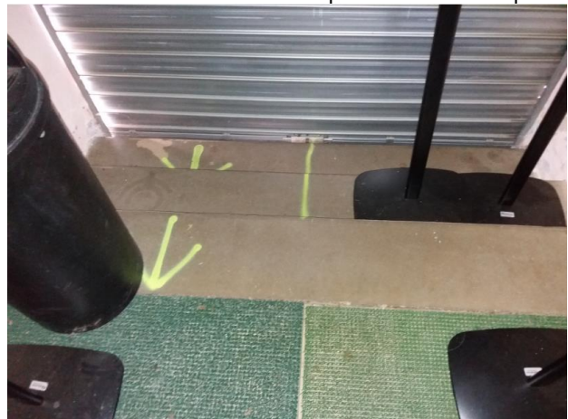
3 marches supplémentaires intérieures de 14,5cm de hauteur (giron de 30cm)
