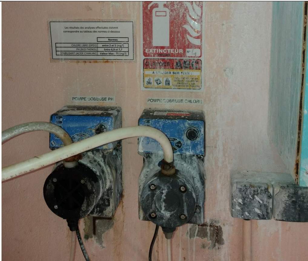
Figure 14 : pompes doseuses
