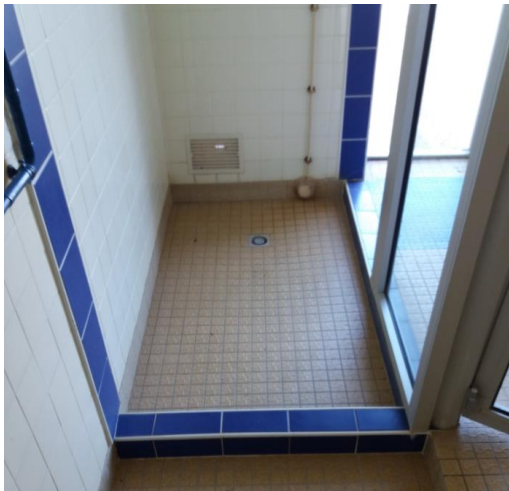
Pédiluve 1 intérieur en sortie de douche
