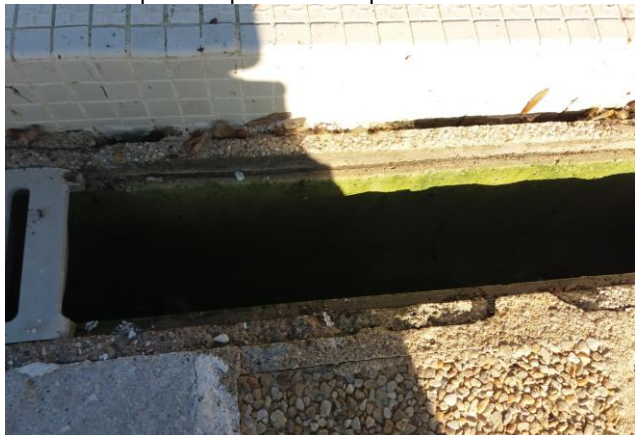
Caniveau préfabriqué béton de profondeur de 8 à 23cm
