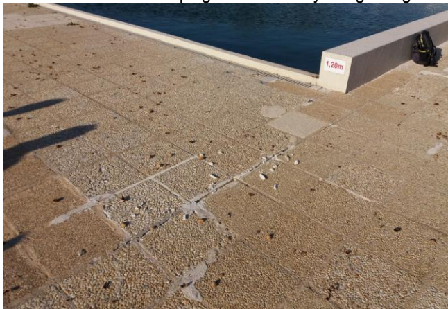
Usure avancée des plages suite aux cycles gel-dégel
