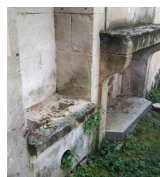
Ancienne cheminée et potager, à Saint-Martin
