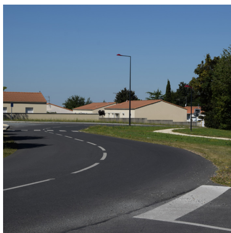
SÉCURISATION DE LA RUE DE BARILLEAU ET DE LA ROUTE DE L'ISLE : 23 270€
