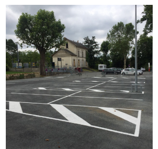
EXTENSION DU PARKING DE LA GARE
