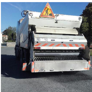
GRAVILLONNAGE DES VOIRIES
