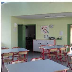
TRAVAUX DANS LES ÉCOLES
