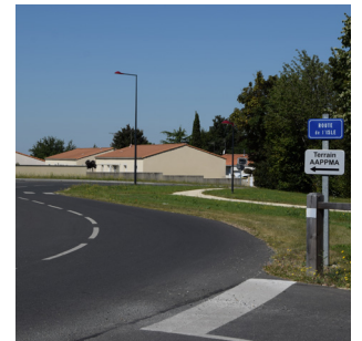
RUE DE BARILLEAU & ROUTE DE L'ISLE
