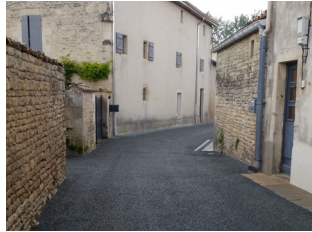
Réfection de la rue des Brandinières
