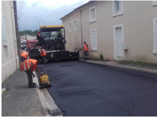
Réfection de la route de François et de la rue de la Villedieu, après travaux d'assainissement
