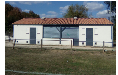
Installation d'une ventilation dans les vestiaires du stade de Breloux
