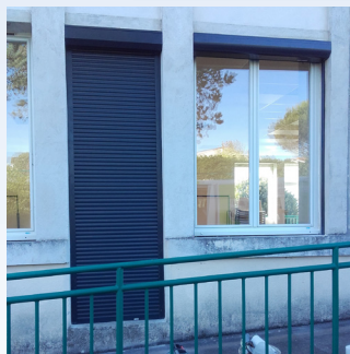
Pose de volets roulants (côté route) Grande salle de Champcornu
