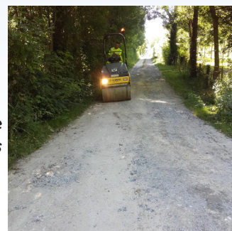
Compactage des chemins blancs
